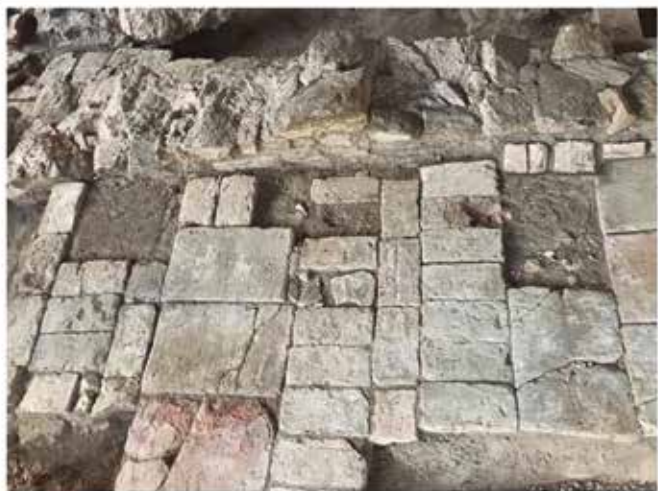
Suelo de la zona de terma.
